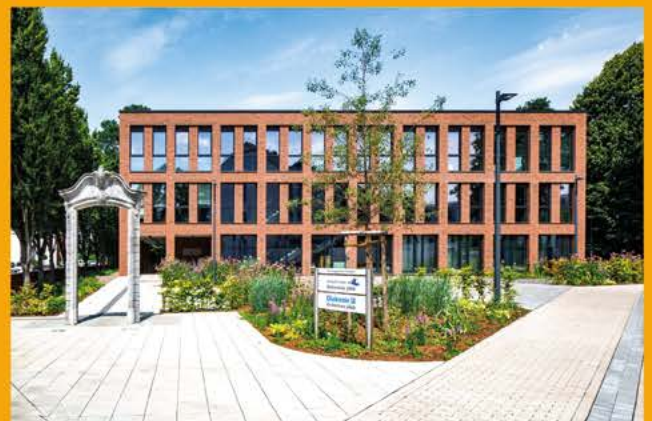
Kirchenkreis Jülich Nachhaltiger Verwaltungsneubau für den Kirchenkreis Jülich mit regionaler Ziegelfassade
